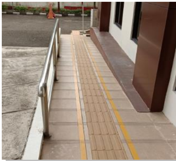
Gambar: Ubin Pemandu ( guiding block ) dan handraill ramp Penyandang Disabilitas
