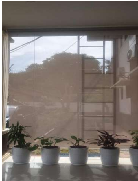
Gambar 5.33 Krei otomatis pada samping teras/lobby belakang kantor PTUN Serang Untuk mengurangi dampak tampias air hujan
