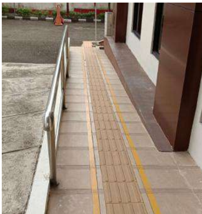
Gambar 5.24. Ubin Pemandu ( guiding block ) dan handraill ramp Penyandang Disabilitas
