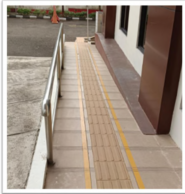
Gambar 5.31. Ubin Pemandu ( guiding block ) dan handraill ramp Penyandang Disabilitas
