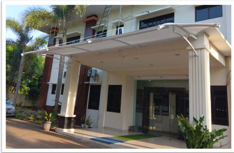
Gambar 5.41 Kanopi pada teras/lobby belakang kantor PTUN Serang Untuk mengurangi dampak tampias air hujan yang sering menggenang
