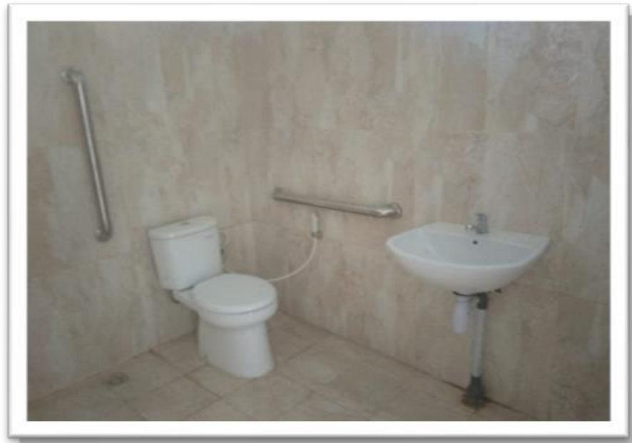
Gambar 5.24. Toilet Khusus Penyandang Disabilitas
