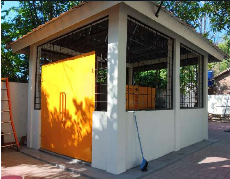
Gambar 5.40 Pembangunan rumah genset dengan kapasitas mesin generator yang memadai untuk mengkover daya listrik seluruh gedung saat terjadi pemadaman listrik dari PLN .
